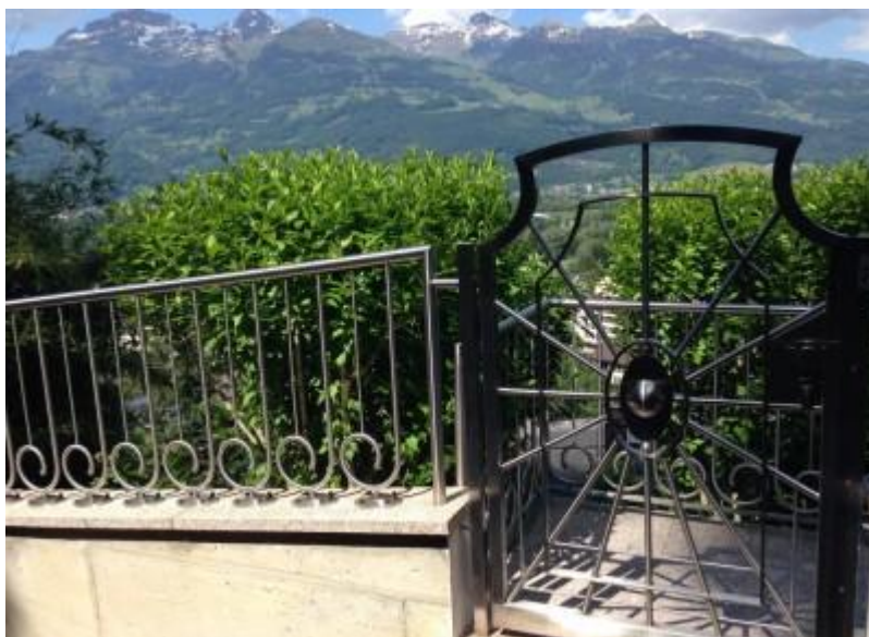
Bilde 125: Gjerde og grunder i massivt rustfritt stål. På vegen opp mot slottet.
